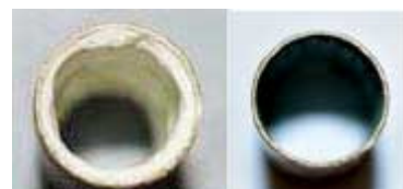
Dépôts calcaires dans une conduite d'eau avant la pose du dynamiseur d'eau, puis quelques semaines après
